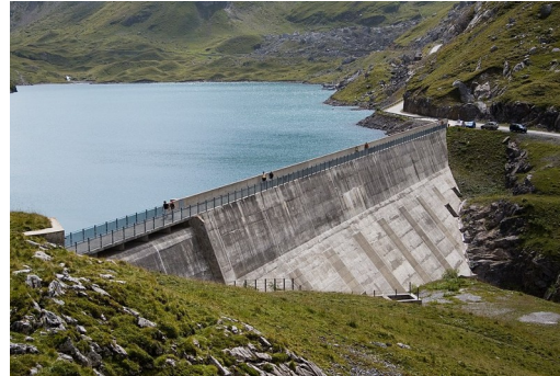
Sanetsch, canton du Valais, Suisse
